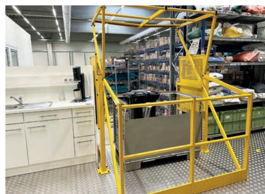
Die mit Mahlgut gefüllte Materialtonne wird mit Hilfe eines Gabelstaplers und eines ausgeklügelten Sicherheitsmechanismus ins Obergeschoss zur zentralen Materialversorgungsanlage gehievt.
