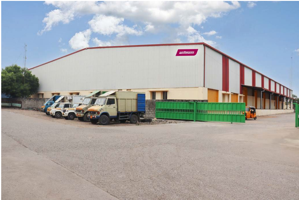
Neue Zentrale WITTMANN BATTENFELD India
