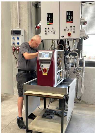
Techniker Kai Nölling am neuen Prüfstand in Meinerzhagen: Mit der Investition hat WITTMANN die Durchlaufzeiten in der Instandhaltung von Temperiergeräten verkürzt. (Bild: WITTMANN)
